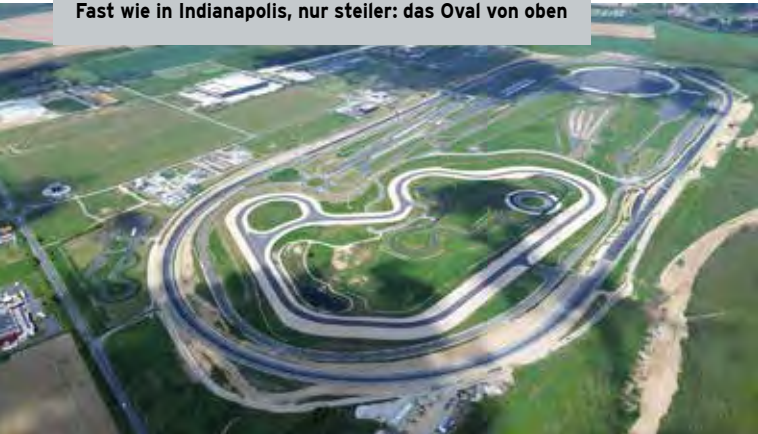
Fast wie in Indianapolis, nur steiler: das Oval von oben
